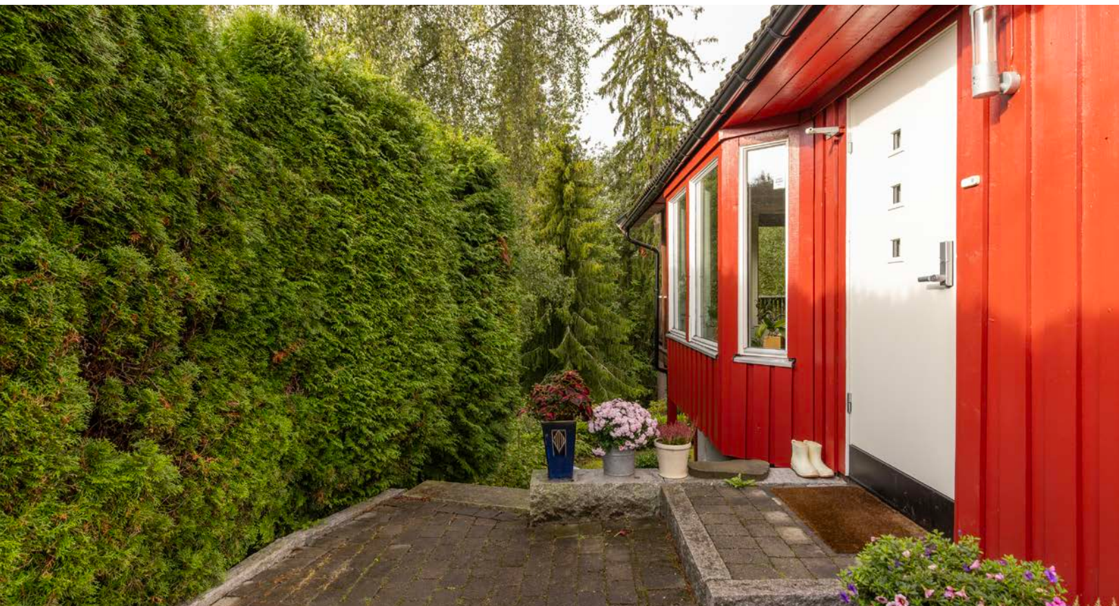
Inngangspartiet har varmekabler
