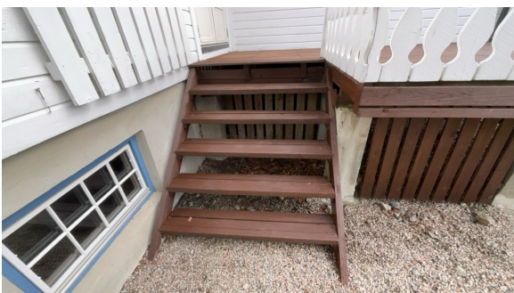
Utvendig trapp i tre.
