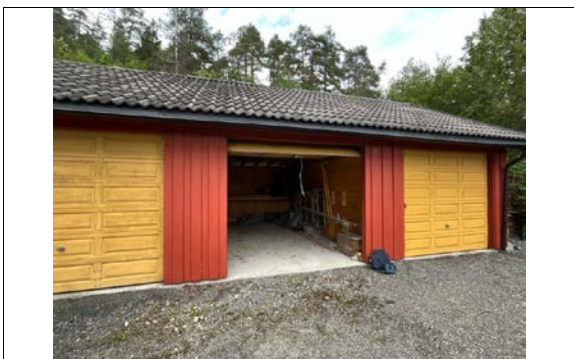
Eneboligen har en midstilt garasjeplass i en rekkegarasje. Garasjen er et sameie. Garasjeplassen er 23m 2 .
