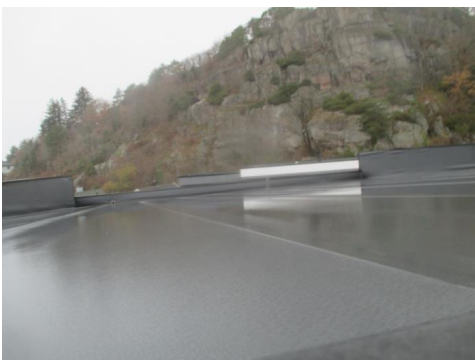
Deler av taktekkingen.
