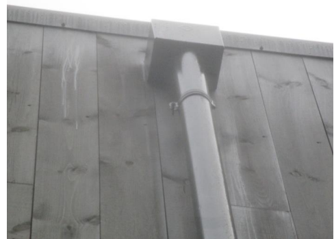
To utvendige nedløp i fra hovedtaket.
