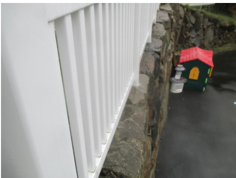
Maskinstablet forstøtningsmur av steinblokker.
