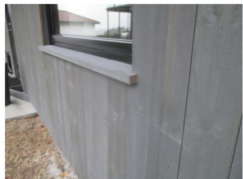
Deler av kledningen med tilhørende belistninger.
