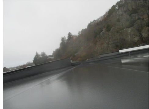
Sett i fra kanten med stige.
