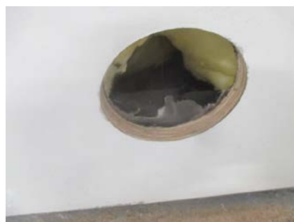
Hulltaking i fra garasje.
