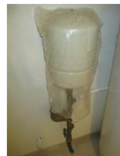
Innvendig stoppekran og trykkttank.
