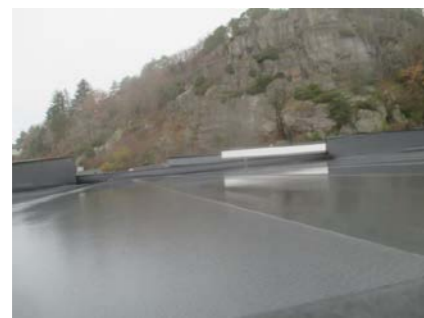
Deler av taktekkingen.
