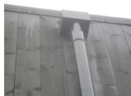
To utvendige nedløp i fra hovedtaket.
