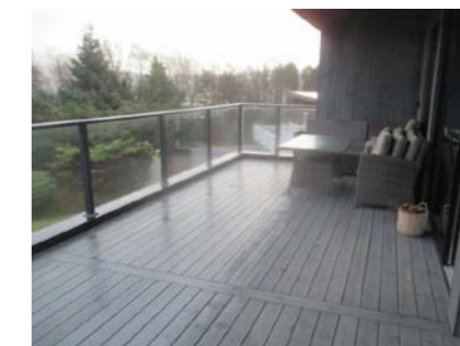
Deler av terrasse med glassrekkverk.
