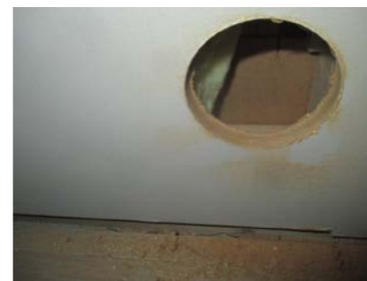
Hulltaking bak garderobe på soverommet.
