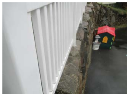
Maskinstablet forstøtningsmur av steinblokker.
