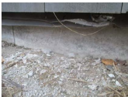
Deler av ringmur.
