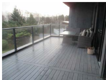
Deler av terrasse med glassrekkverk.
