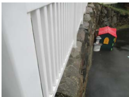
Maskinstablet forstøtningsmur av steinblokker.
