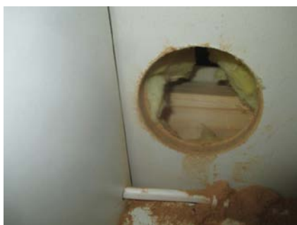
Hulltaking i kjøkkenbenken.
