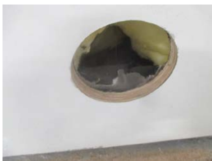
Hulltaking i fra garasje.
