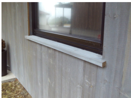
Deler av kledningen med tilhørende belistninger.
