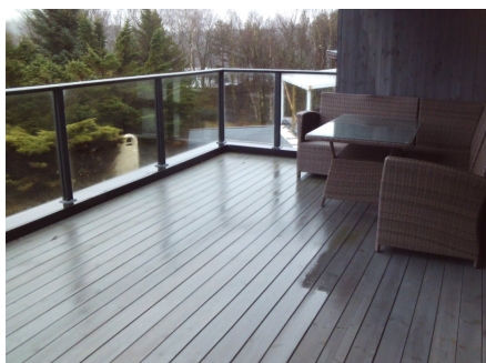
Deler av terrasse med rekkverk.
