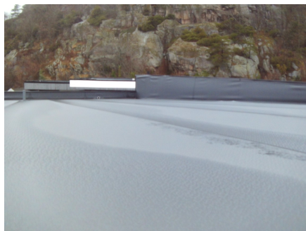
Deler av taktekkingen.
