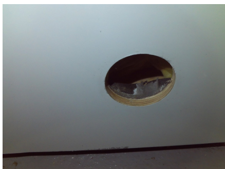
Hulltaking i fra garasje.
