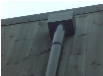
Nedløp i fra hovedtaket.
