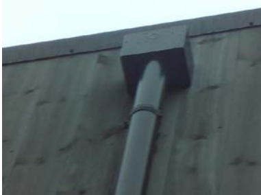
Nedløp i fra hovedtaket.
