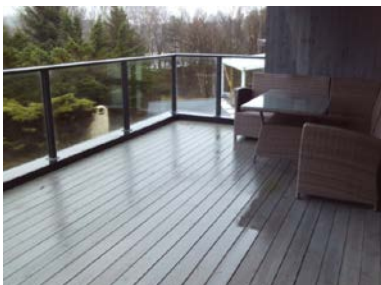
Deler av terrasse med rekkverk.
