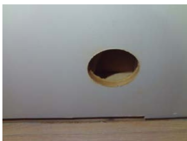
Hulltaking fra bak garderobeskap.
