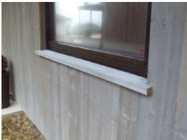
Deler av kledningen med tilhørende belistninger.
