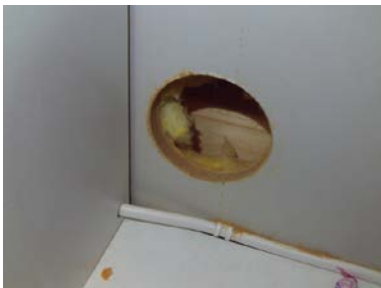
Hulltaking i fra benkeskap på kjøkke
