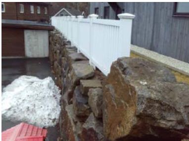
Maskinstablet forstøtningsmur av større steinblokker.
