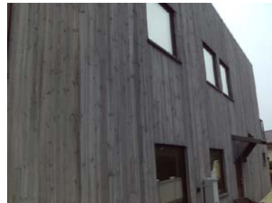
Deler av ene fasaden
