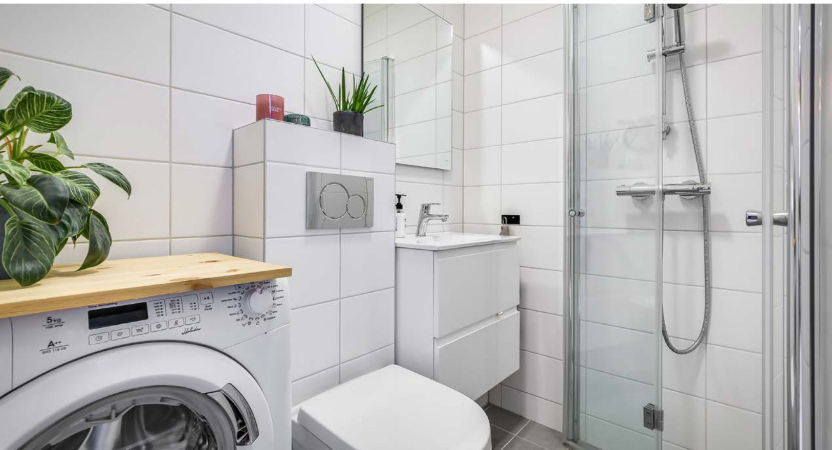
Flislagt bad fra 2021 med opplegg for vaskemaskin.
