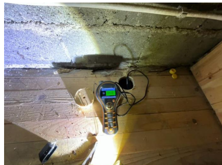
Kontroll av gulv under trapp
