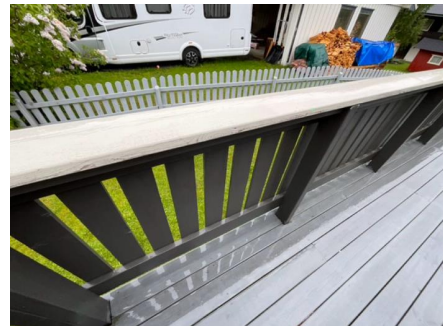
Bilde av slitt overflate på rekkverk
