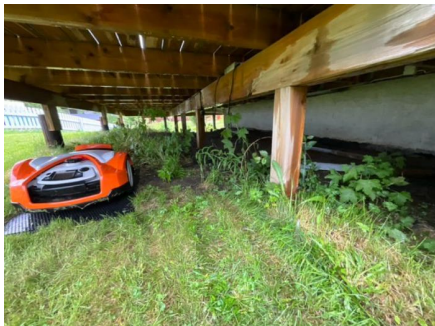
Bilde av konstruksjon
