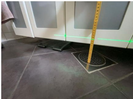
Målt sluk under servant
