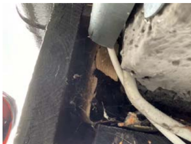
Bilde av luftesjikt i ytterhjørne
