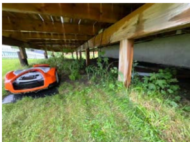
Bilde av konstruksjon
