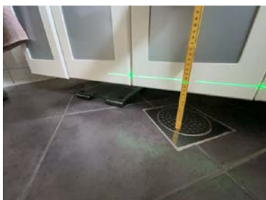
Målt sluk under servant
