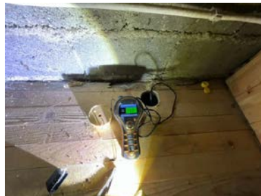
Kontroll av gulv under trapp
