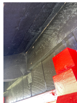
Synlige nedbøyninger i takkonstruksjon
