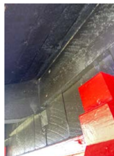
Synlige nedbøyinger i takkonstruksjon
