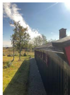
Synlige nedbøyinger i takkonstruksjon
