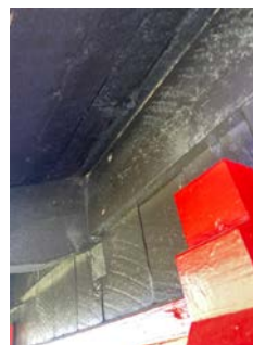
Synlige nedbøyinger i takkonstruksjon
