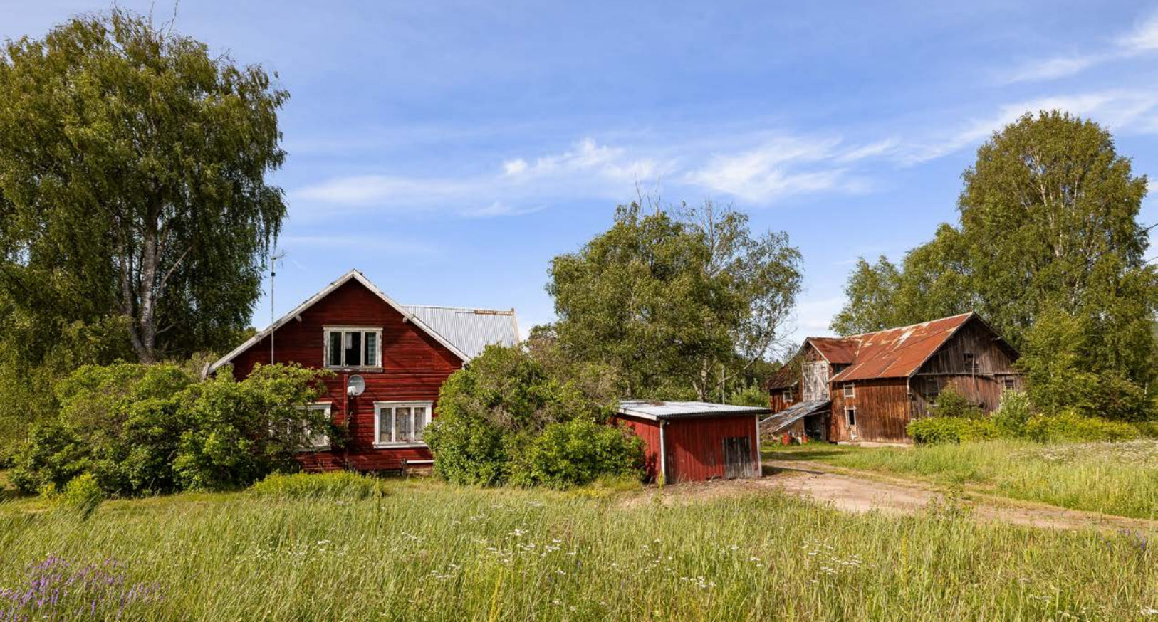
Bygningsmassen er å anse som kondemnabel.
