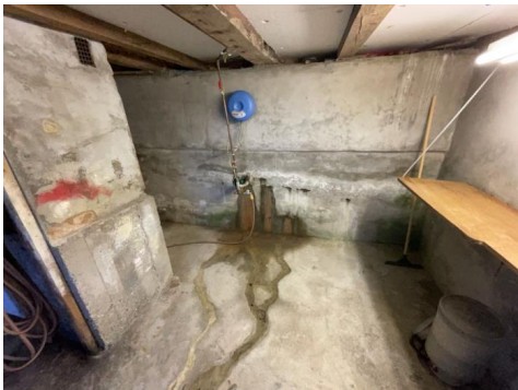
Synlig fukt gjennomtrengning i bakmur
