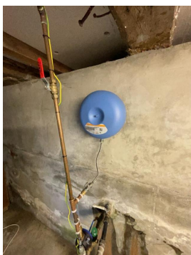
Ekspansjonskar er montert ved hovedstoppekrane.
