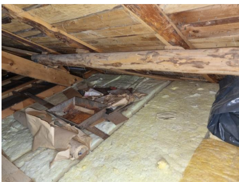
Nedbøyning i taksida nedfor pipe på forsida av boligen
