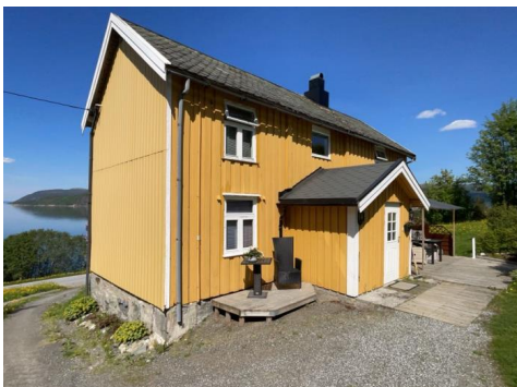
Oversikt. Vegg mot fjøs har stålplatetekking.
