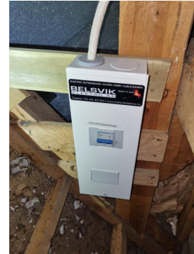
Hovedsikring plassert på kryploft
