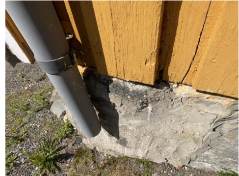
Råte i enkelte bord på oversiden av boligen
