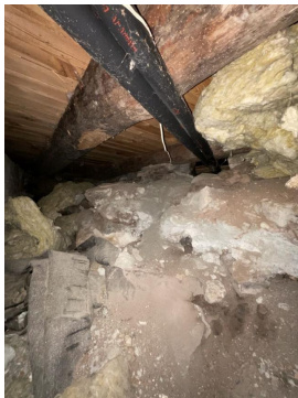
Krypkjeller er ikke mulig å kontrollere grunnet lav høyde
