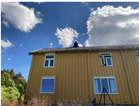
Nedbøyning i taksida nedfor pipe på forsida av boligen
