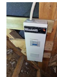
Hovedsikring plassert på kryploft
