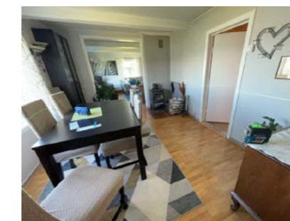
1. etasje Plassering av laser ved kontroll av stue 1. Det er målt 25 mm høydeforskjell gjennom rommet. TG 2
