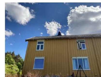
Nedbøyning i taksidene nedfor pipe på forsiden av boligen
