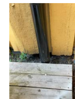
Taknedløp er ført til terreng
