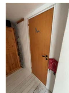
Dør til soverom 4 sett fra gang i 2. etasje
