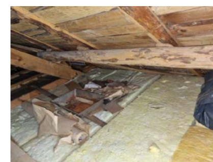
Nedbøyning i taksidene nedfor pipe på forsiden av boligen
