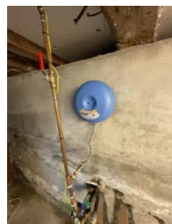
Ekspansjonskar er montert ved hovedstoppekrane.
