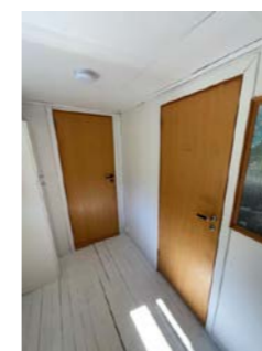
Dør til soverom 2 og 3 sett fra gang i 2. etasje
