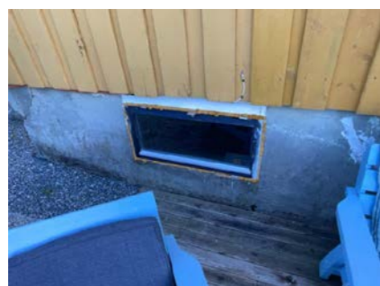
Vinduer i kjeller er montert uten karm og har ikke mulighet for å åpnes.
