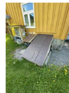
Nedgang til kjeller er beskyttet med vannfast finner som hengslede dører
