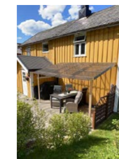
Det er heng i takkonstruksjon på terrassetak, ingen fare ved bruk på sommeren. Veldig viktig at takkonstruksjon slås sammen på vinteren
