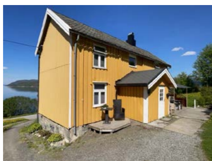
Oversikt. Vegg mot fjøs har stålplatedekking.
