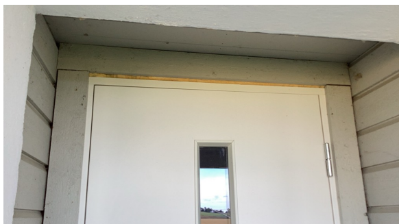
Omramming/listverk dekker ikke over på karm. Synlig isolasjonsskum.
