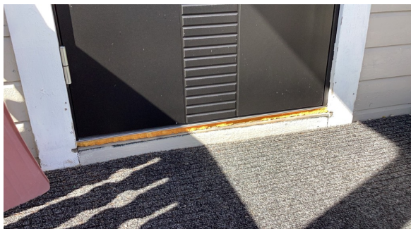
Omramming/listverk dekker ikke over på karm. Synlig isolasjonsskum.
