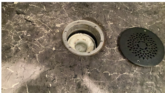
Kontroll av sluk.
