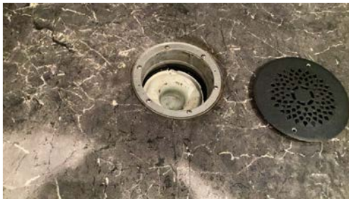
Kontroll av sluk.
