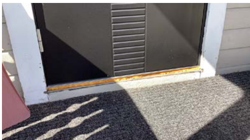
Omrømming/listverk dekker ikke over på karm. Synlig isolasjonsskum.
