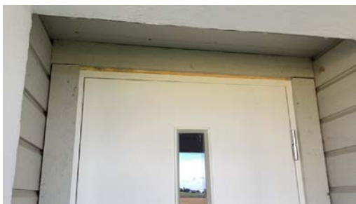
Omrømming/listverk dekker ikke over på karm. Synlig isolasjonsskum.
