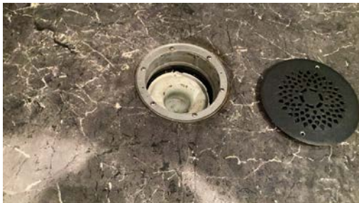
Kontroll av sluk.
