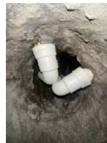
Eldre sluk med ukjent tettesjikt.
