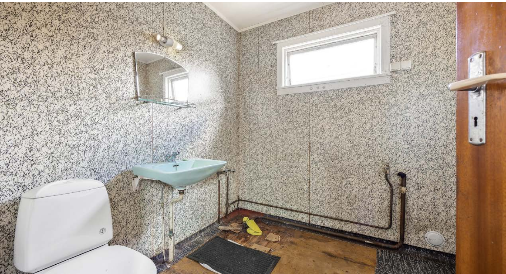
Badet er klar for renovering, men størrelsen på rommet tilsier at det er plass til både dusj og vaskemaskin her.
