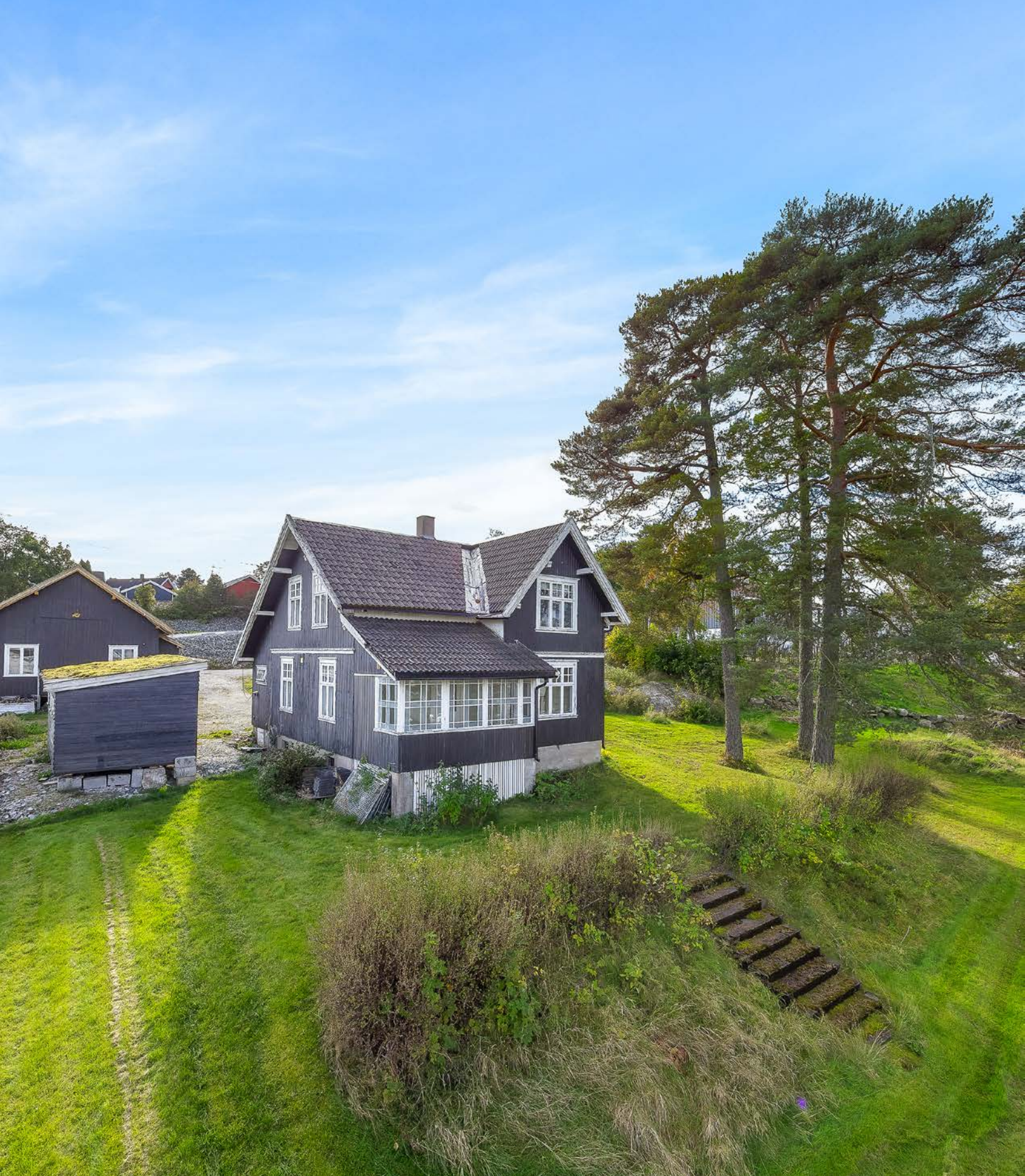
De originale vinduene i vinterhagen gir huset den rette, klassiske karakteren.
