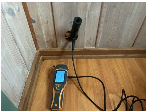
Måling av fukt i svill/påforet vegg med pigger.
