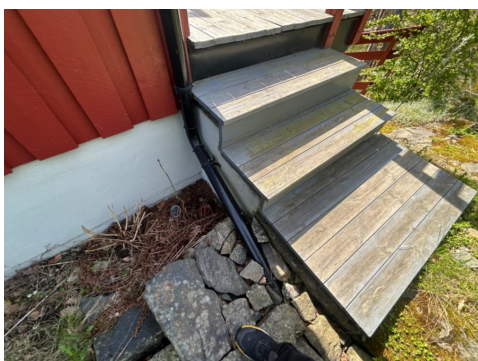
Trapp til terrasse
