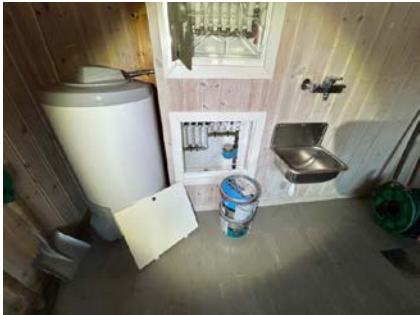
Varmtvannsbereider.
