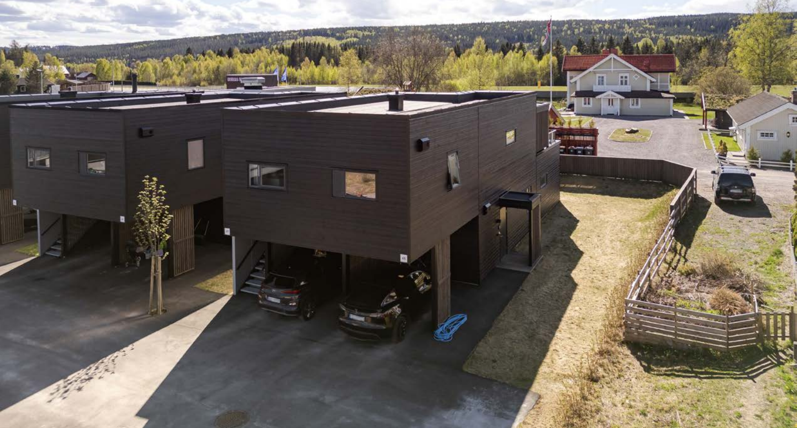
Parkering i inntilbygget carport med elbil-lader.
