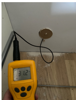
Ingen fukt målt i vegg ved hulltaking
