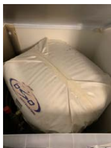
Bereder plassert i bad i innbyggingskasse
