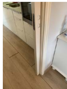
Bilde illustrer noe av oppsprekte bord
