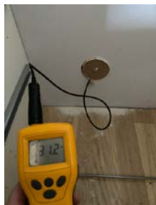
Ingen fukt målt i vegg ved hulltaking
