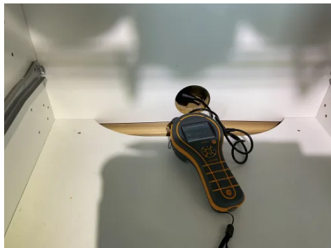
Hulltaking i tilstøtende rom.
