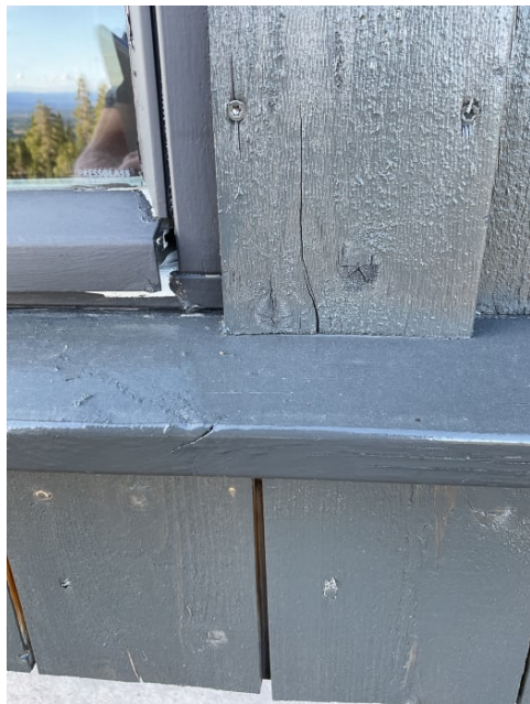
Kort avstand mellom panel og vannbrett.
