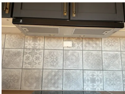
Ventilator og komfyrvakt.
