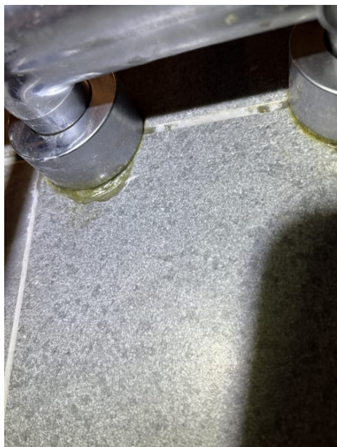
Gjennomføring tett med fugemasse.
