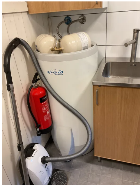
Varmtvannsbereder.
