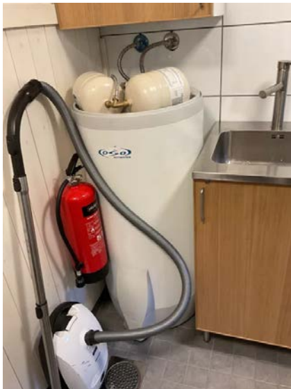
Varmtvannsbereder.
