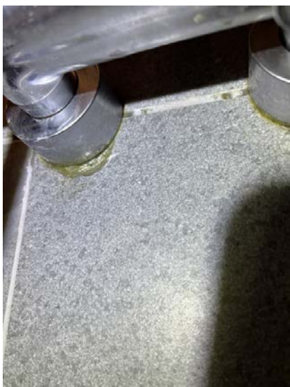
Gjennomføring tettet med fugemasse.
