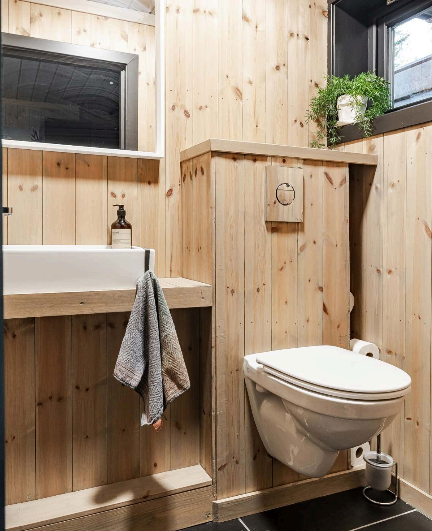
Separat toalettrom med veggengt toalett og servant.
