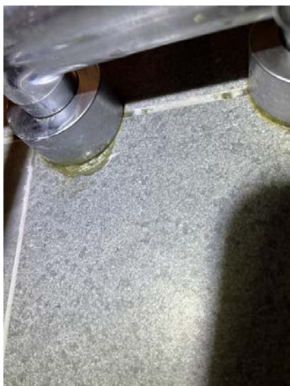
Gjennomføring tettet med fugemasse.
