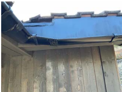
Ødelagt takrenne.
