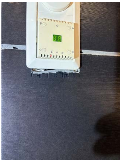
Utett løsning rundt lysbryter.
