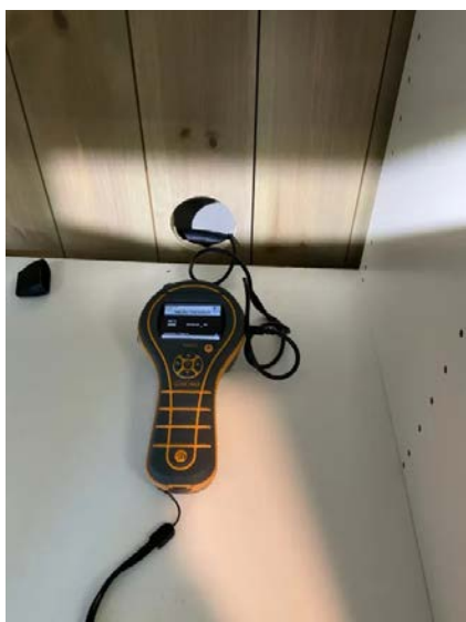
Hulltaking i tilstøtende rom.
