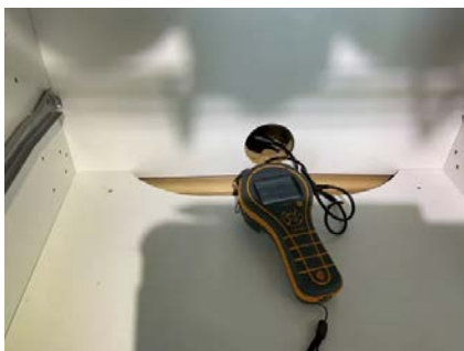
Hulltaking i tilstøtende rom.
