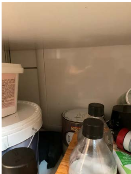
Fordelerskap til vann.
