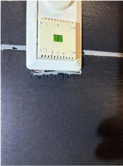
Utett løsning rundt lysbryter.
