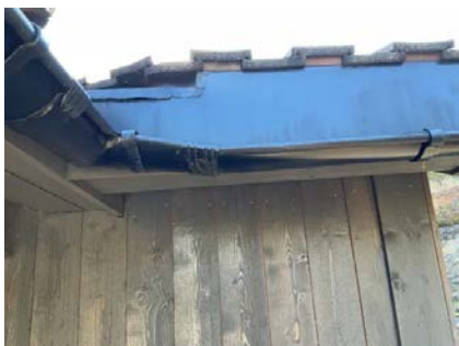
Ødelagt takrenne.
