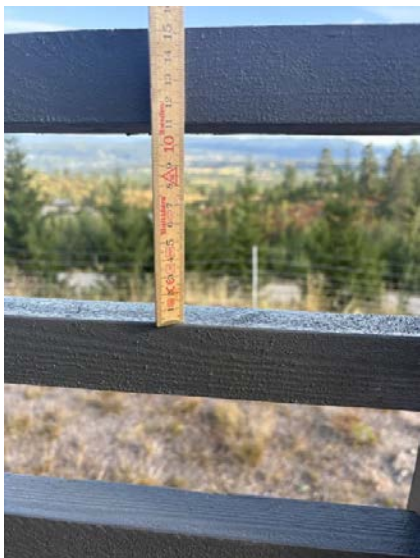
Åpning i rekkverket.
