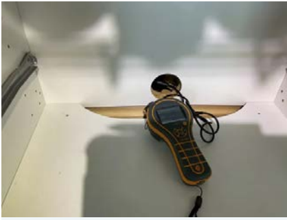
Hulltaking i tilstøtende rom.
