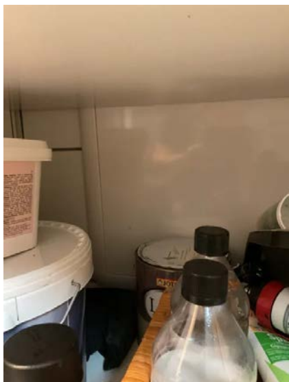
Fordelerskap til vann.
