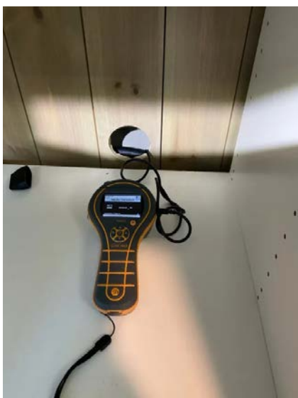
Hulltaking i tilstøtende rom.
