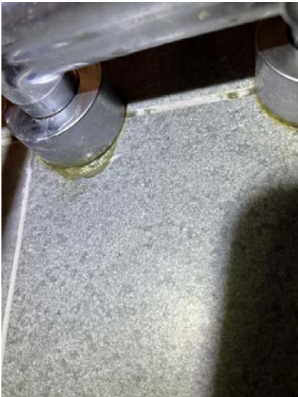
Gjennomføring tett med fugemasse.
