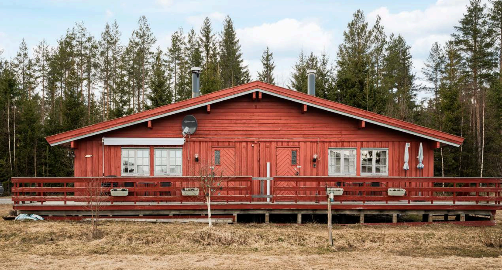
124 A til høyre og 124 B til venstre. Solrik terrasse mot syd hvor det er montert markise utenfor vinduene til B.
