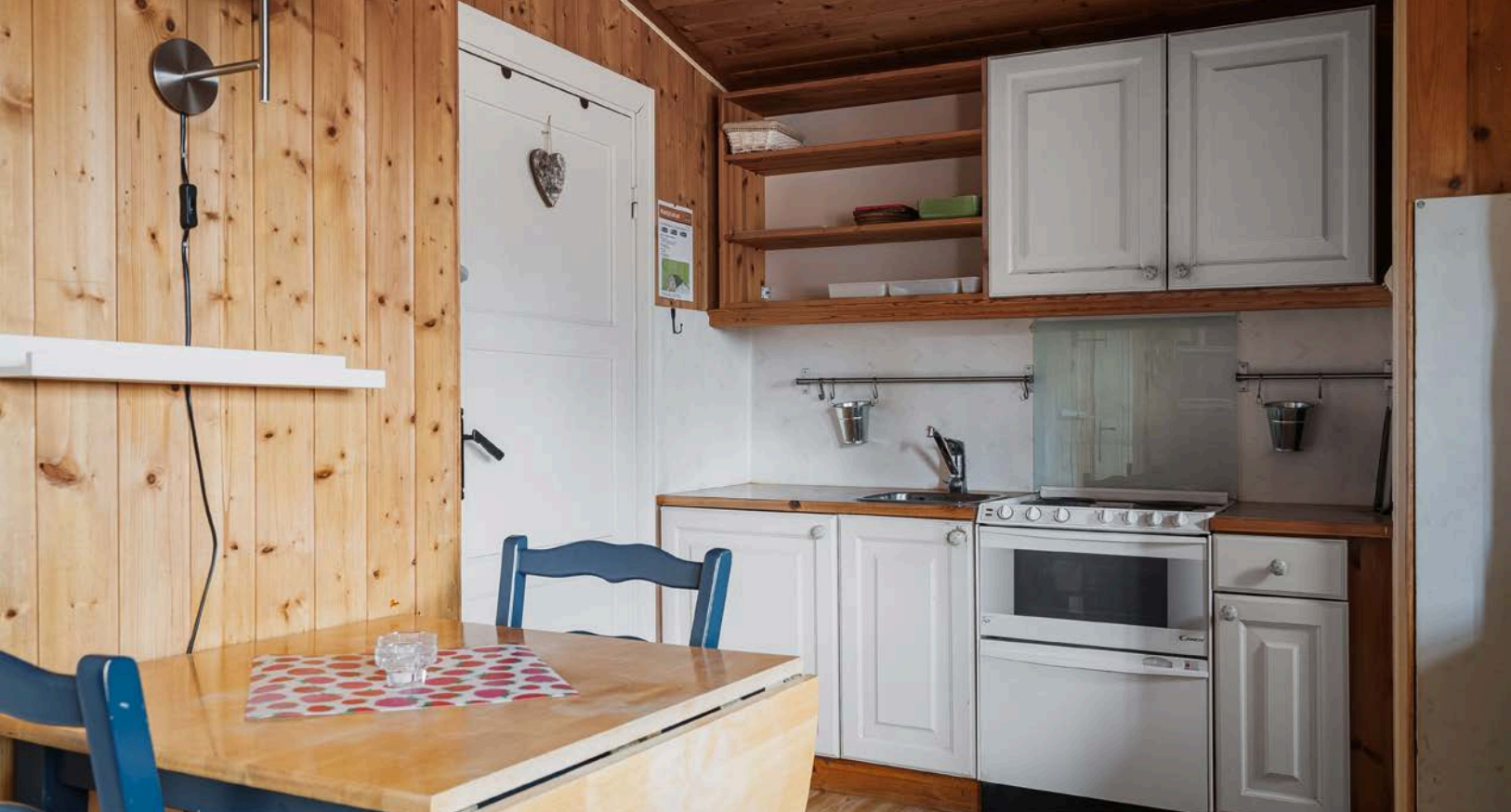
Hyttene holder en enkel hyttestandard og noe modernisering bør påregnes.
