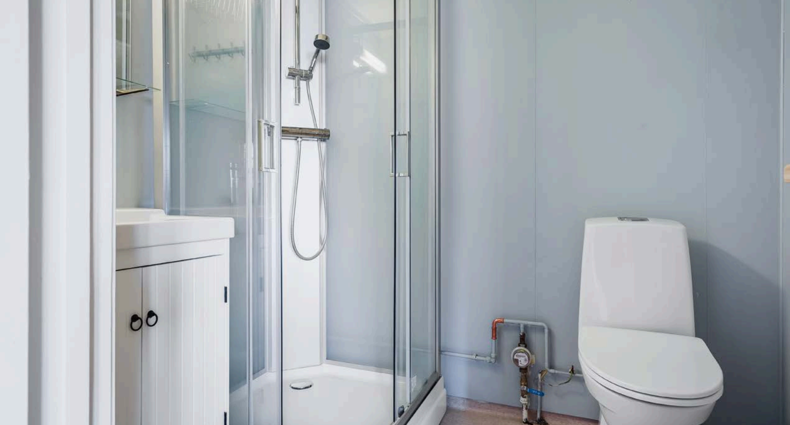
Baderom med belegg på gulv og våtromsplater på veggene.
