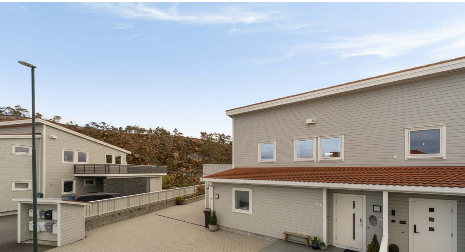
Pent opparbeidet innkjørsel, med belegningsstein og markterrasse foran inngangsparti.
