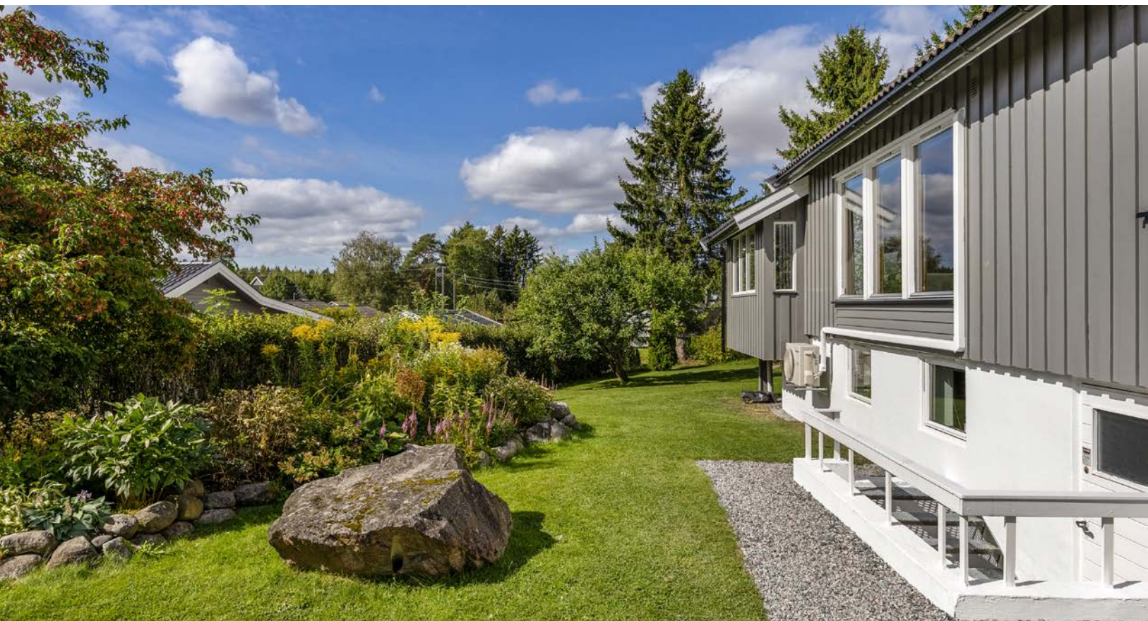
Utvendig adkomst til kjelleretasjen.
