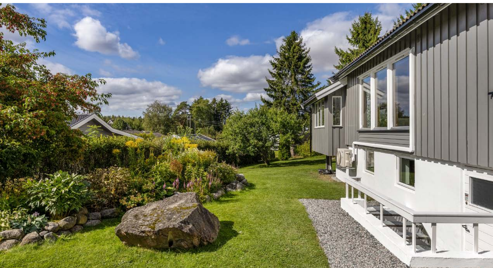
Utvendig adkomst til kjelleretasjen.
