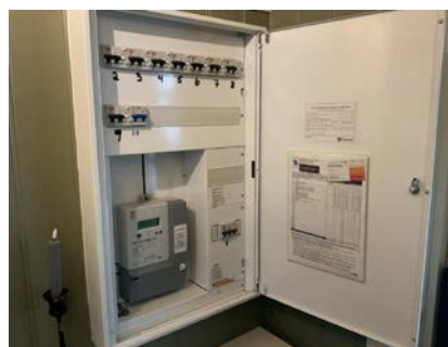
Sikringsskap 1.etg
