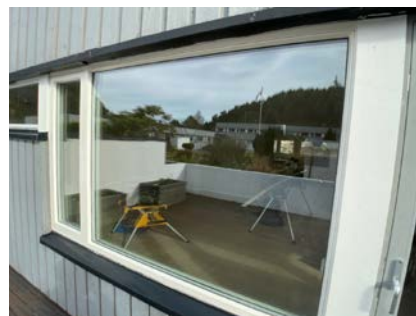
Vindu med 3-lags glass fra 2026
