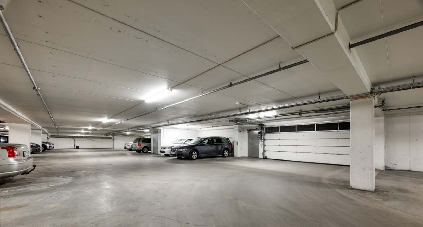
Parkeringskjeller som tar deg tørrskodd helt opp til leiligheten
