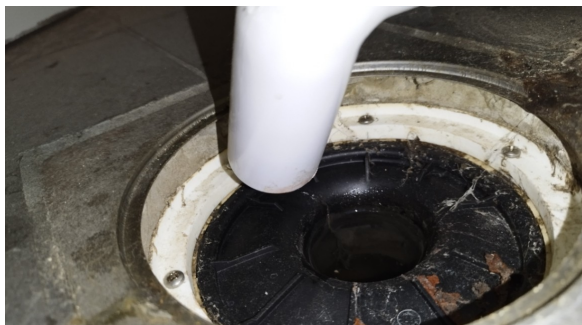
Kontroll av sluken.
