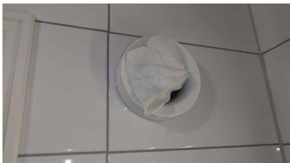
Test av avtrekket.
