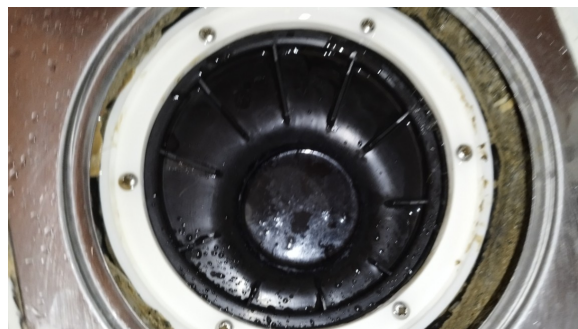
Kontroll av sluk.
