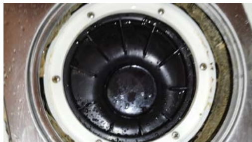
Kontroll av sluk.
