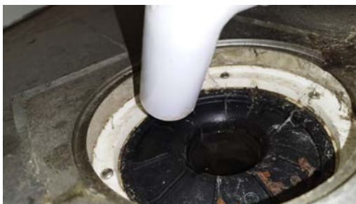
Kontroll av sluken.
