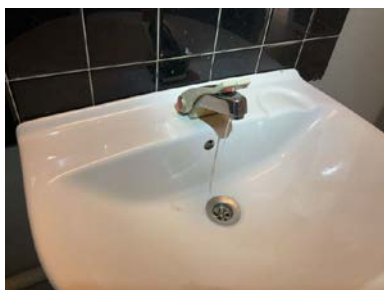
Armatur lar deg ikke stenge og varmtvann står og renner.
