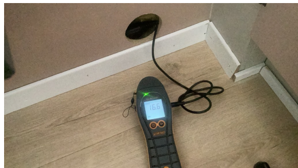
Ved fuktmåling registrerte jeg tørre verdier.
