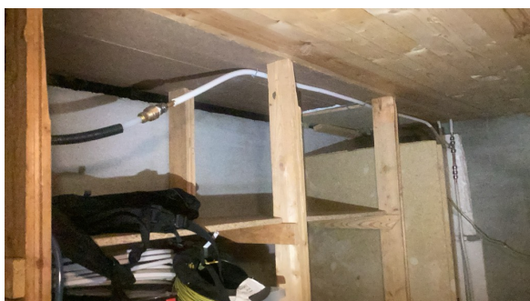
Løse vannledninger.
