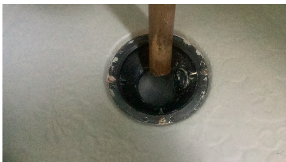
Kontroll av sluk.
