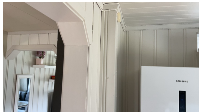
Ikke synlig pipevange
