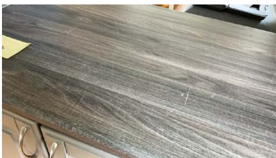
Slitasje på benkeplate
