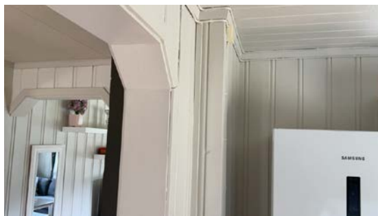
Ikke synlig pipevange
