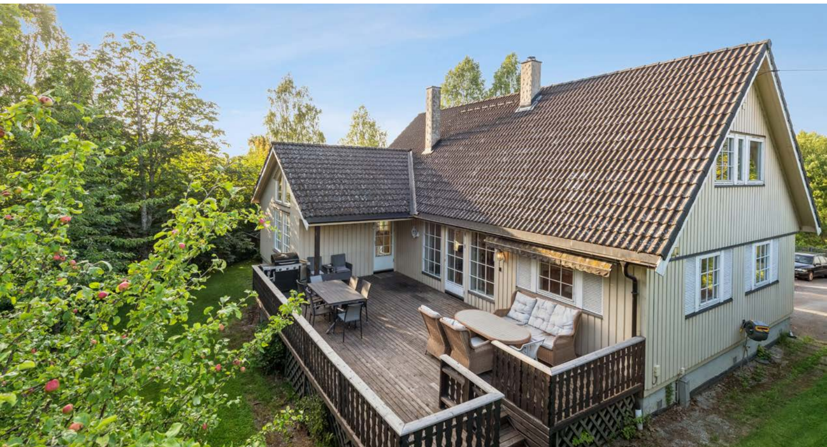
Huset ble tilbygget i 2004, og da ble det samtidig langt ny drenering og ny takstein på gammel del.
