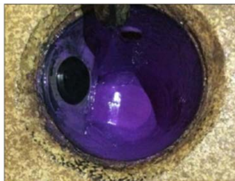
Fig. 17: Sluk med ny vannlås, behandlet med epoksy. Kilde: Leverandør 1
