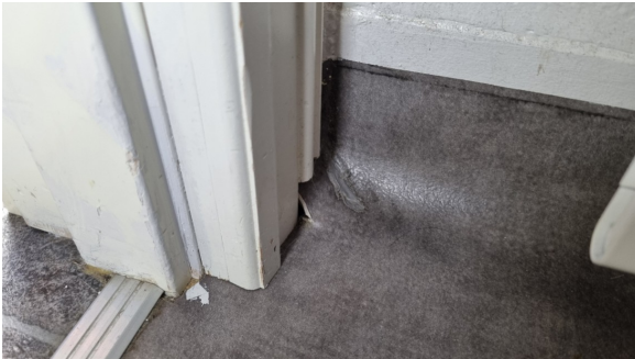
Utettheter i belegg.
