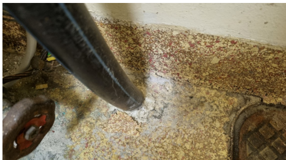
Utvendig vannledning er av nyere dato.
