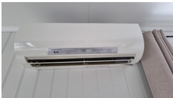
Varmepumpe fra 2008.
