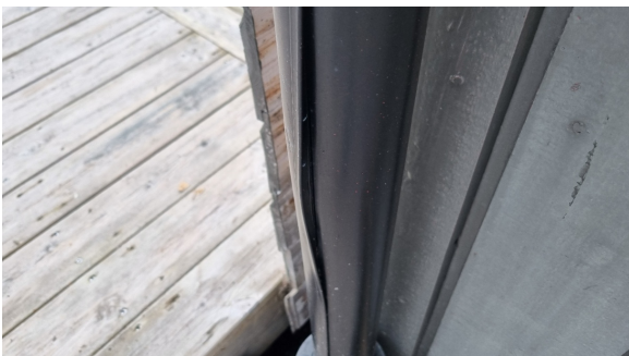
Det er utettheter i nedløp.
