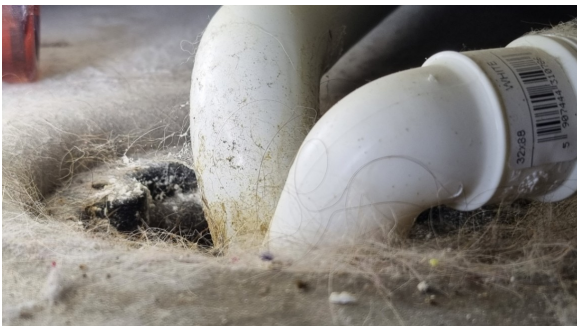
Kontroll av sluk.
