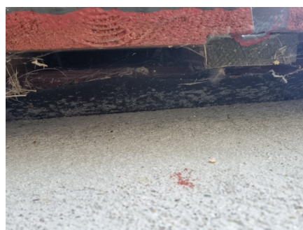
Det er ingen musesperre i nedre kant av konstruksjon.
