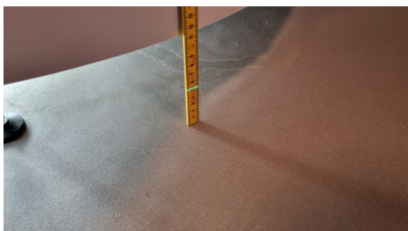
Kontroll av fall til sluk.
