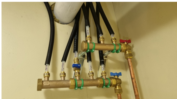
Vannledninger av plast (rør-i-rør) er fra 2024.
