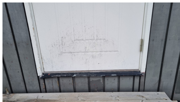
Ytterdør i hovedetasjen
