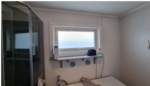
Det er vindu i våtsonen ved dusjkabinett.
