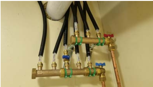
Vannledninger av plast (rør-i-rør) er fra 2024.
