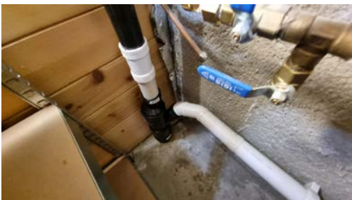
Det er avløpsrør av plast.
