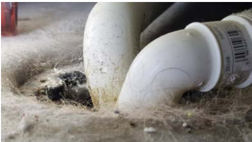
Kontroll av sluk.
