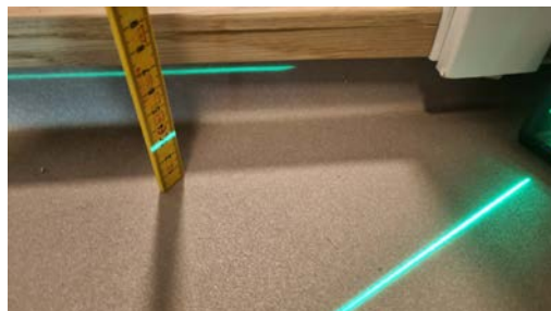
Kontroll av fall til sluk.
