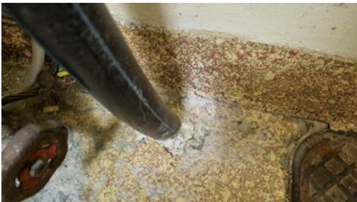
Utvendig vannledning er av nyere dato.
