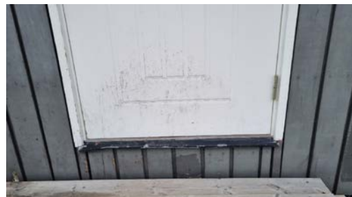
Ytterdør i hovedetasjen
