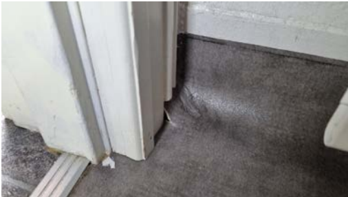
Utettheter i belegg.
