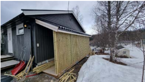
Takoverbygget platt på gavlvegg mot øst
