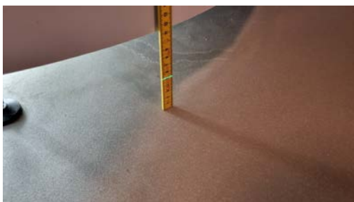
Kontroll av fall til sluk.
