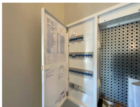
Sikringsskap leilighet
